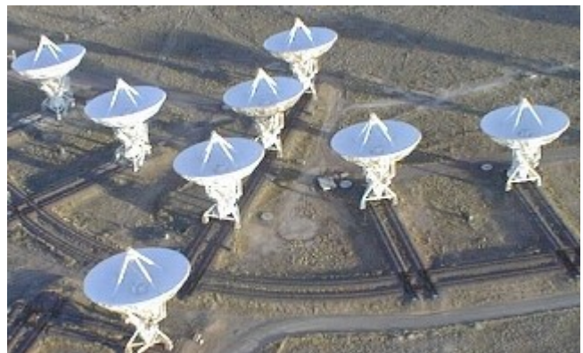
Illustrazione 3: VLA New Mexico - 27x25m antennas
